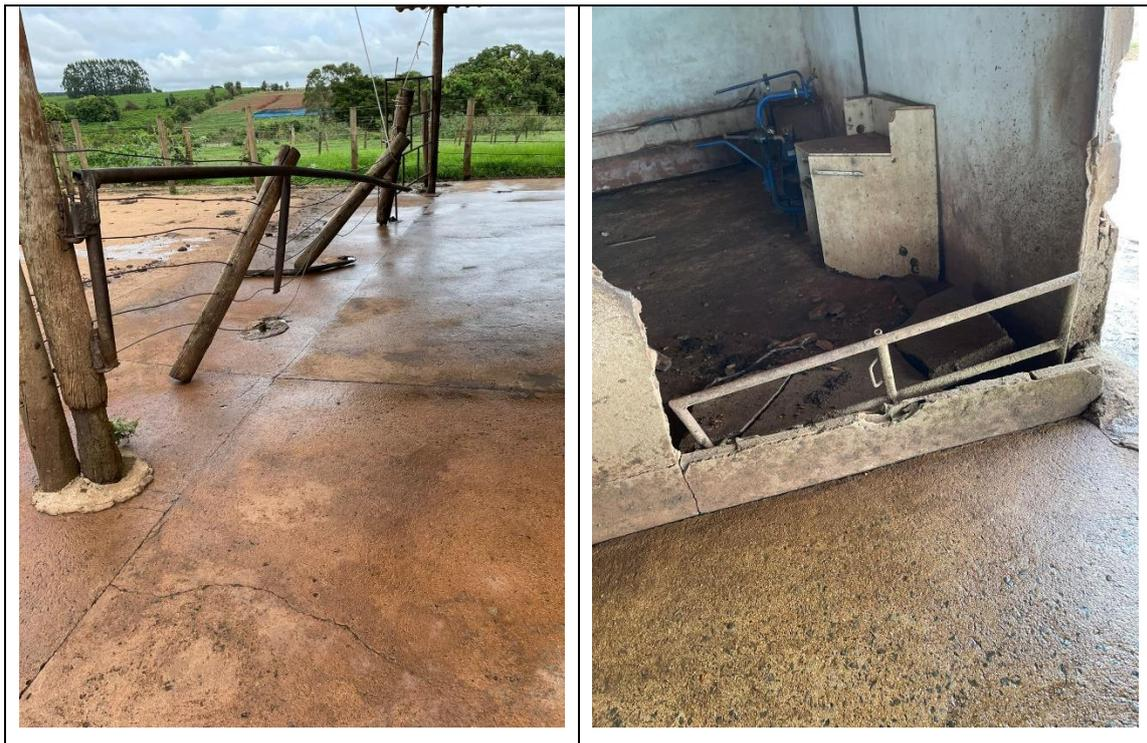
**Figura 4.** Madeiramento danificado e presença de material pontiagudo exposto.
