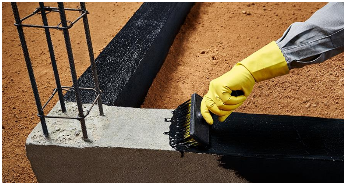
Figura 9 – Aplicação do Neutrol tinta asfáltica
