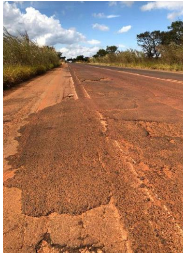
Figura 10 – Acostamento danificado.
