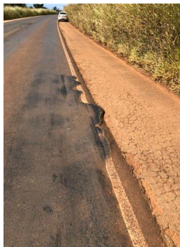
Figura 7 – Escorregamento asfáltico.
