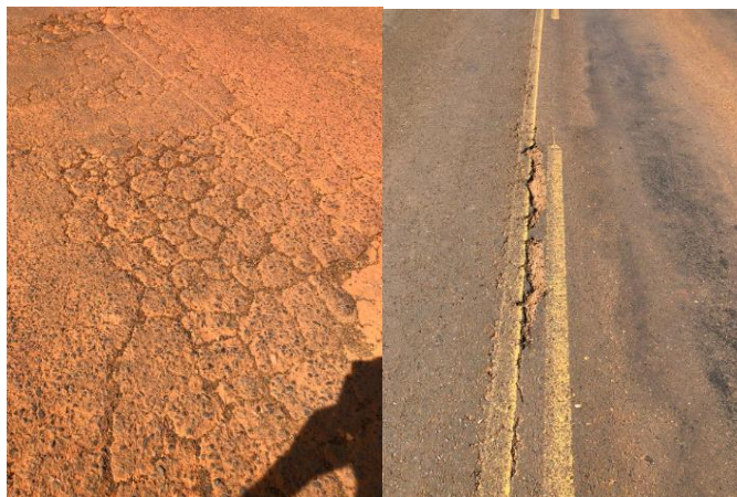
Figura 6 – Tricas tipo jacaré e trinca longitudinal
