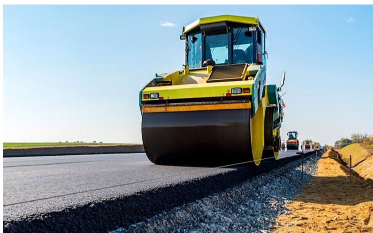
Figura 1 - Aplicação de revestimento asfáltico
