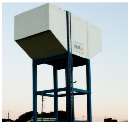
Figura 5 – Reservatório Elevado da Catulina.
